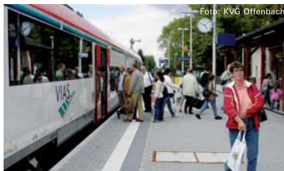
Neu: Der Bahnsteig Seligenstadt nach seinem Umbau.
