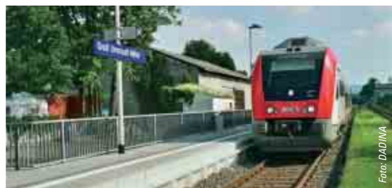
Besser ein- und aussteigen können die Fahrgäste im Bahnhof Groß-Umstadt Mitte. Hier ist der neue Bahnsteig seit einigen Wochen fertiggestellt.
