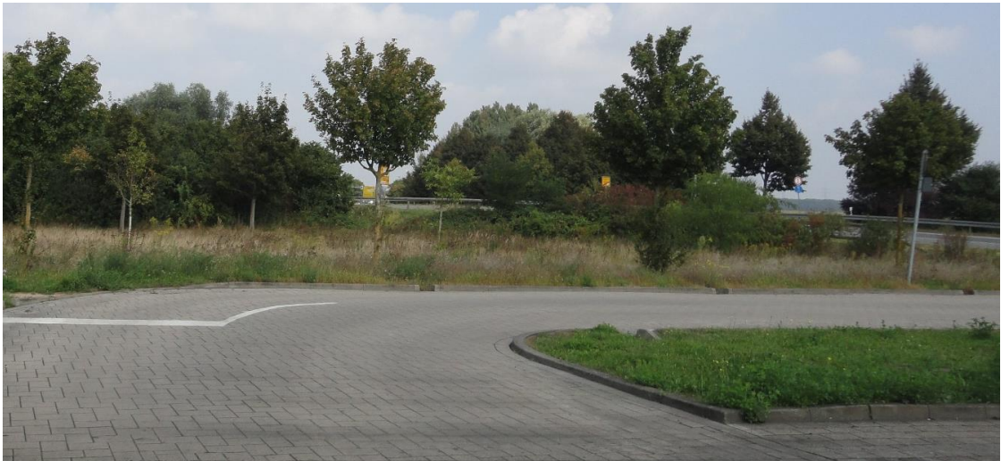
Abbildung 9 Höhendifferenzen im nördlichen Bereich der Haltestelle Dreieichweg in Arheilgen (Blick in Richtung Frankfurter Landstraße)
